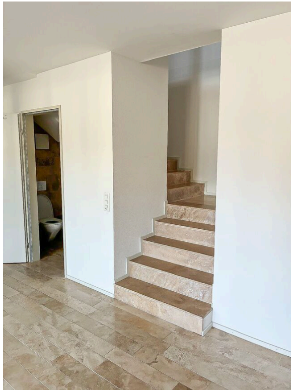
Treppenaufgang im DG
